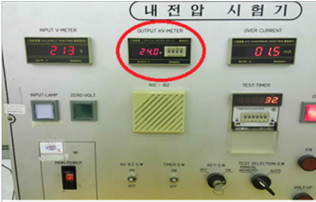
그림 5. 동작전압 20kV의 1.2배 전압(24kV)으로 수행한 내전압 시험
